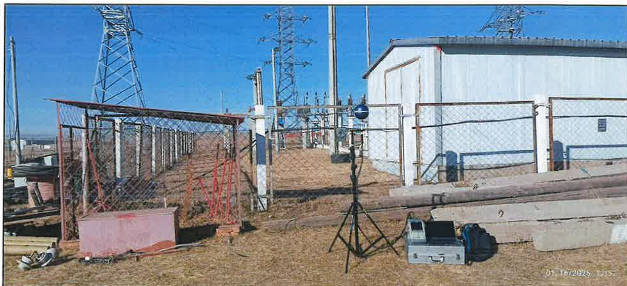
Зураг 2. Улаанбаатар хот, Багануур дүүрэг, 35/10 кВ-ын Байдлаг дэд станц орчимд хэмжилт хийх үеийн зураг.
