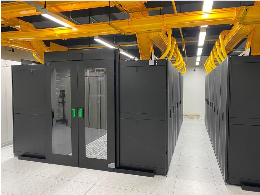
Зураг 3: Серверийн өрөө, шилэн хаалгаар хаагдсан хэсэг нь хүйтэн коридор бөгөөд хөргөлтийн хүйтэн агаар өргөгдсөн шалан доороос үлээдэг
