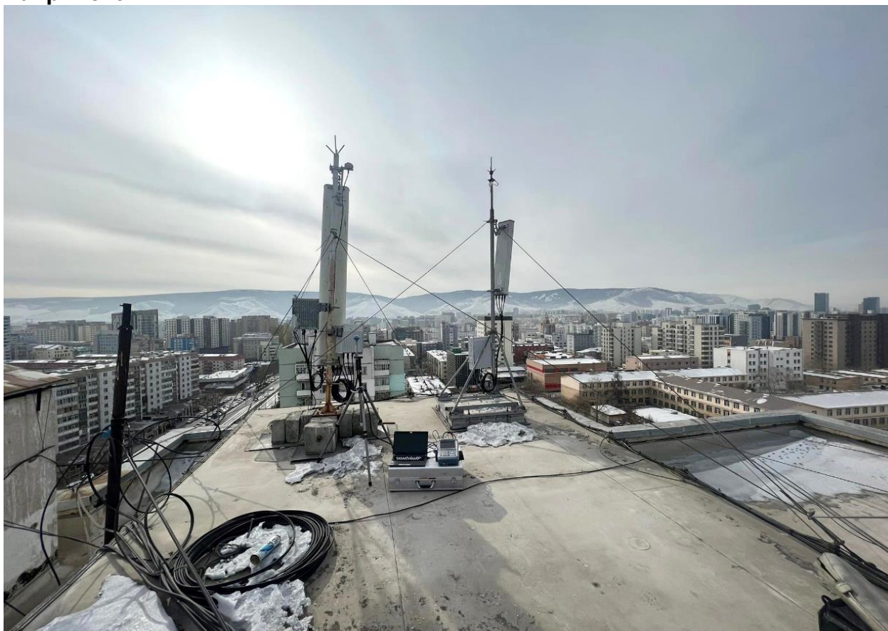
Зураг №1 БЗД 3-р хороо 3А байрны дээвэр дээр хэмжилт хийж байгаа байдал
