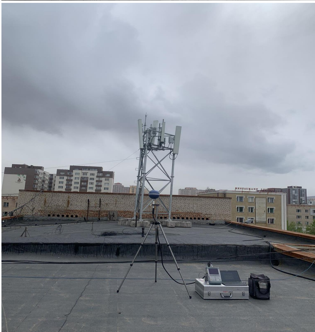
Зураг №1 УБТЗамын эмнэлгийн байрны дээвэр дээр хэмжилт хийж байгаа байдал
